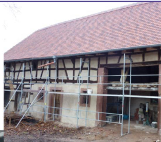
La Cour des Tanneurs poursuit sa réhabilitation. Couverture, ravalement de façade, gouttière, démolition de l'appentis, réfection des murs d'enceinte ont été réalisés. Suite des opérations au prochain numéro...
